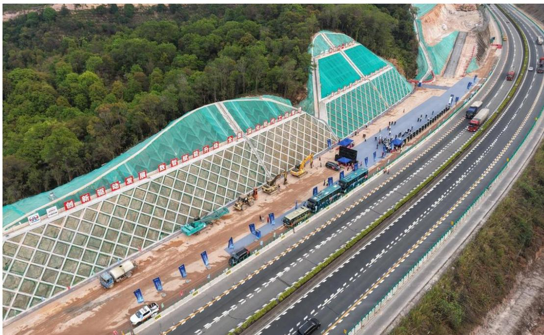
为破解安全管理难题，项目引入智能管理“黑科技”。通过智能监控平台，可实时监测旦架哨隧道洞内作业及人员分布情况，强化安全进度“双管控”；在全线边坡布设智能监测预警系统，运用卫星遥感技术测量边坡关键位置的三维坐标变化，检测边坡位移趋势，及时发现潜在的安全隐患，实现全天候智能实时“把脉”。同时，大力推进施工工艺标准化、规范化，助力项目高质量发展。
