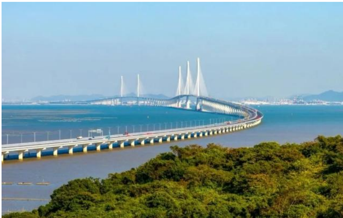
黄茅海跨海通道
