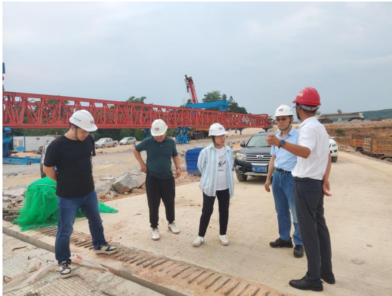
调研桥梁架设情况
