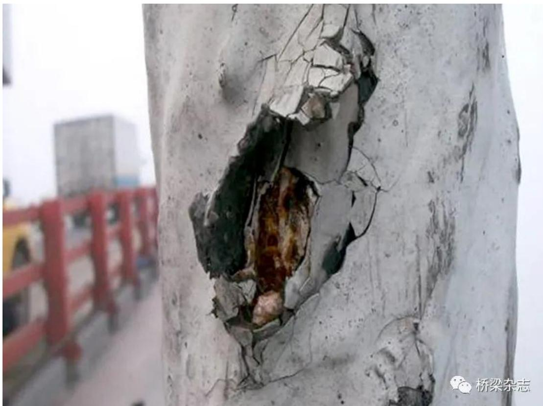
面漆开裂脱落
