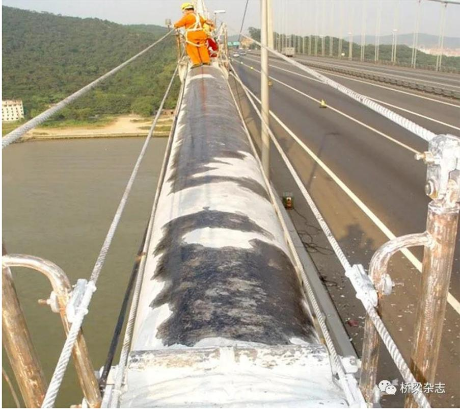
防腐涂装层剥落
